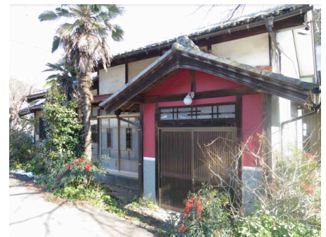
ジャッキーハウスの様子
